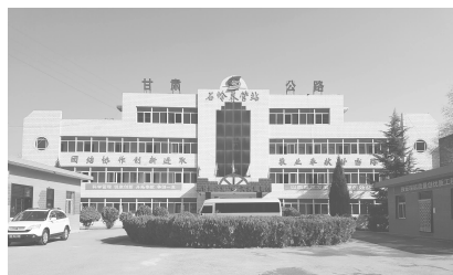
武山公路段石岭养管站建成于2000年
