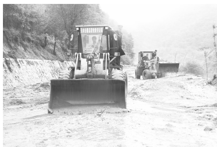
2010年8月12日拍摄于江天路陇南 管辖路段水毁抢险现场
