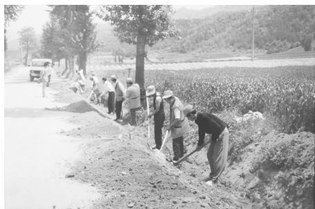
八十年代,麦积公路段百花道班职工在原国道310线土路上利用边沟尺、线绳、铁锨、洋镐人工整修边沟。
