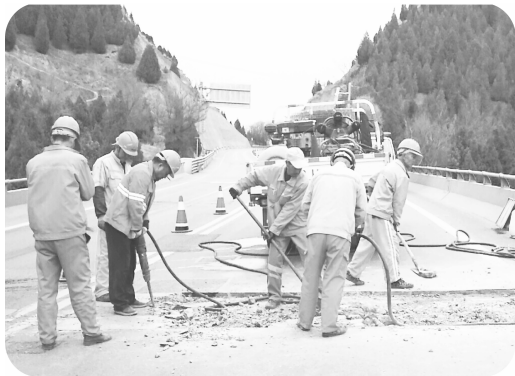
公路人对路面坑槽进行铣刨处理
