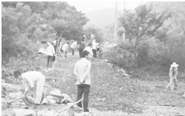
七十年代末八十年代初,水毁发生后,公路段职工在国道 310 线利用铁锹、洋镐、架子车修筑公路便道。
