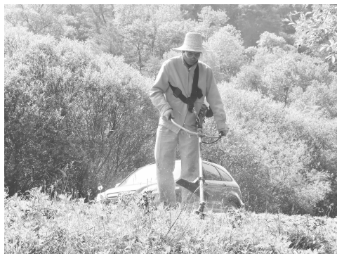
2013年9月拍摄于S305线寺张公路上磨 养管站职工利用打草机清除路肩高草
